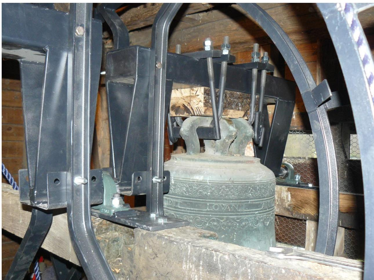
La suspension de la petite cloche et les volants pour actionner les deux cloches. Remarquons aussi que l'axe de rotation de la cloche est situé à hauteur du cou de la cloche (c-à-d plus bas que dans l'installation initiale). Le battant ne comporte pas de contrepoids et il frappe le bas de la pince. Il est abaissé à l'aide d'une pièce métallique qui ressemble à une grande épingle à nourrice (voir photos page précédente).
