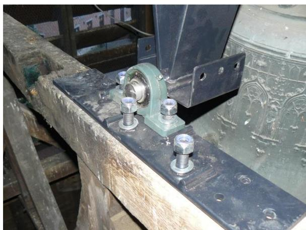
La suspension est montée sur roulement à billes
